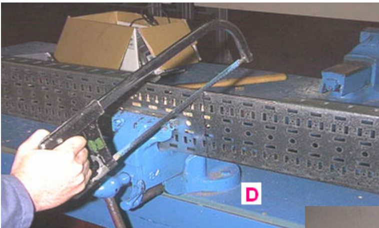
Figure 86: Construct a flat Bend 90° (D)
